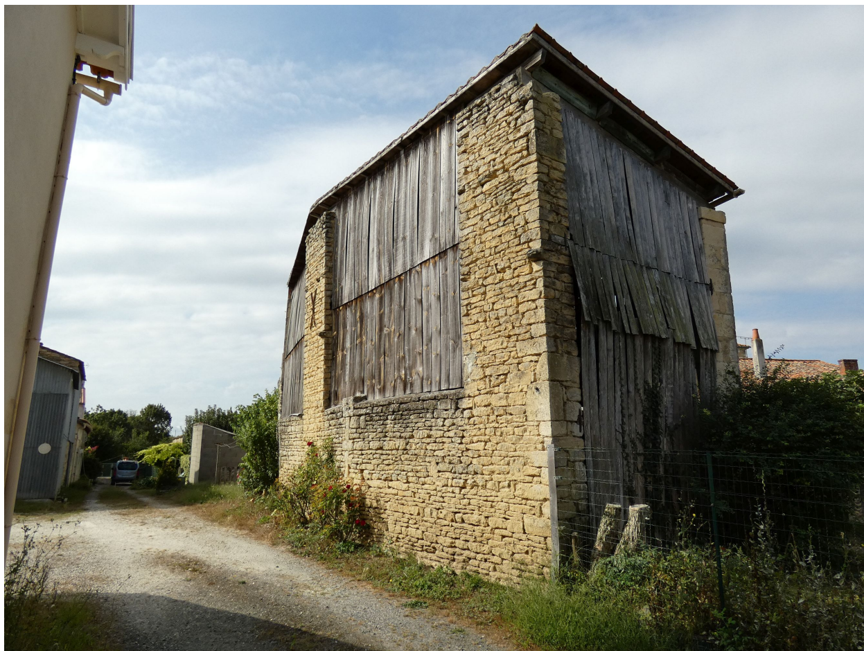
Le fenil vu depuis le nord-est.
