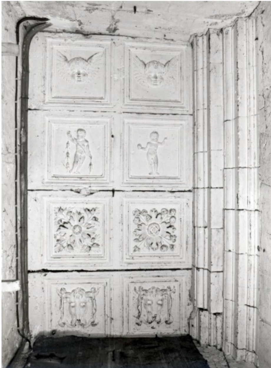
Corps d'entrée : plafond du passage couvert, partie gauche.
