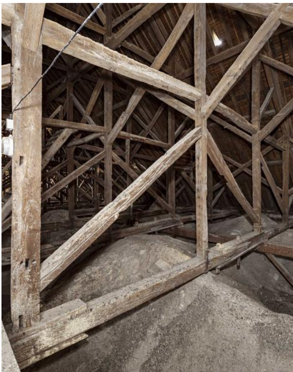
Vue d'un poinçon et des arbalétriers.
