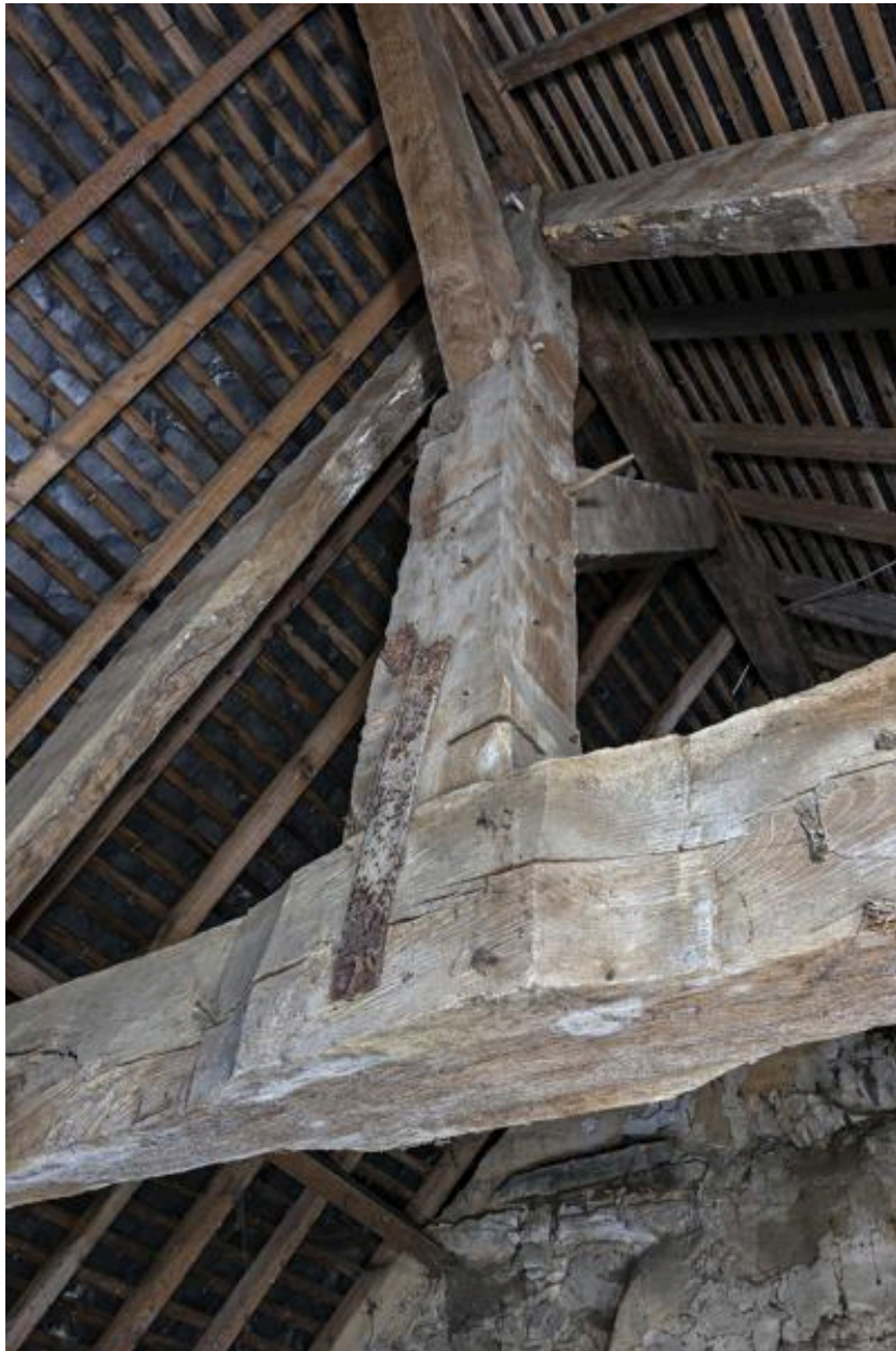
Corps de logis sud, ferme de charpente.
