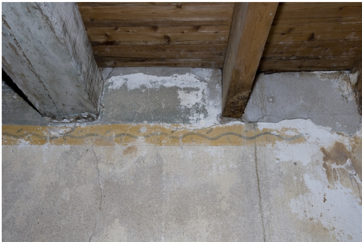
Détail de la frise peinte à droite de la poutre centrale.
