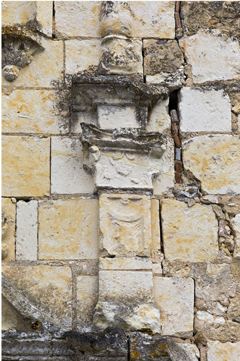
Portail, détail du décor : petit pilastre à droite du fronton trapézoïdal.
