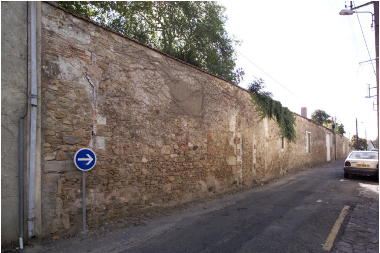
Le mur de clôture rue Beausoleil.
