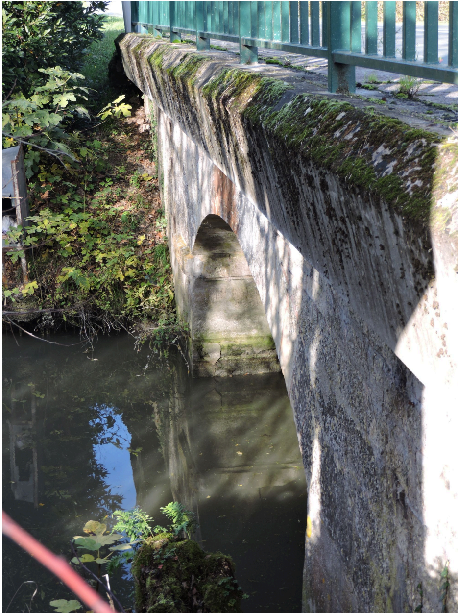
L'arche du pont sur le canal de Vix, côté aval.
