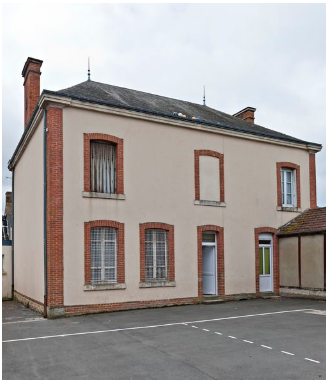
Mairie-logement, élévation postérieure.
