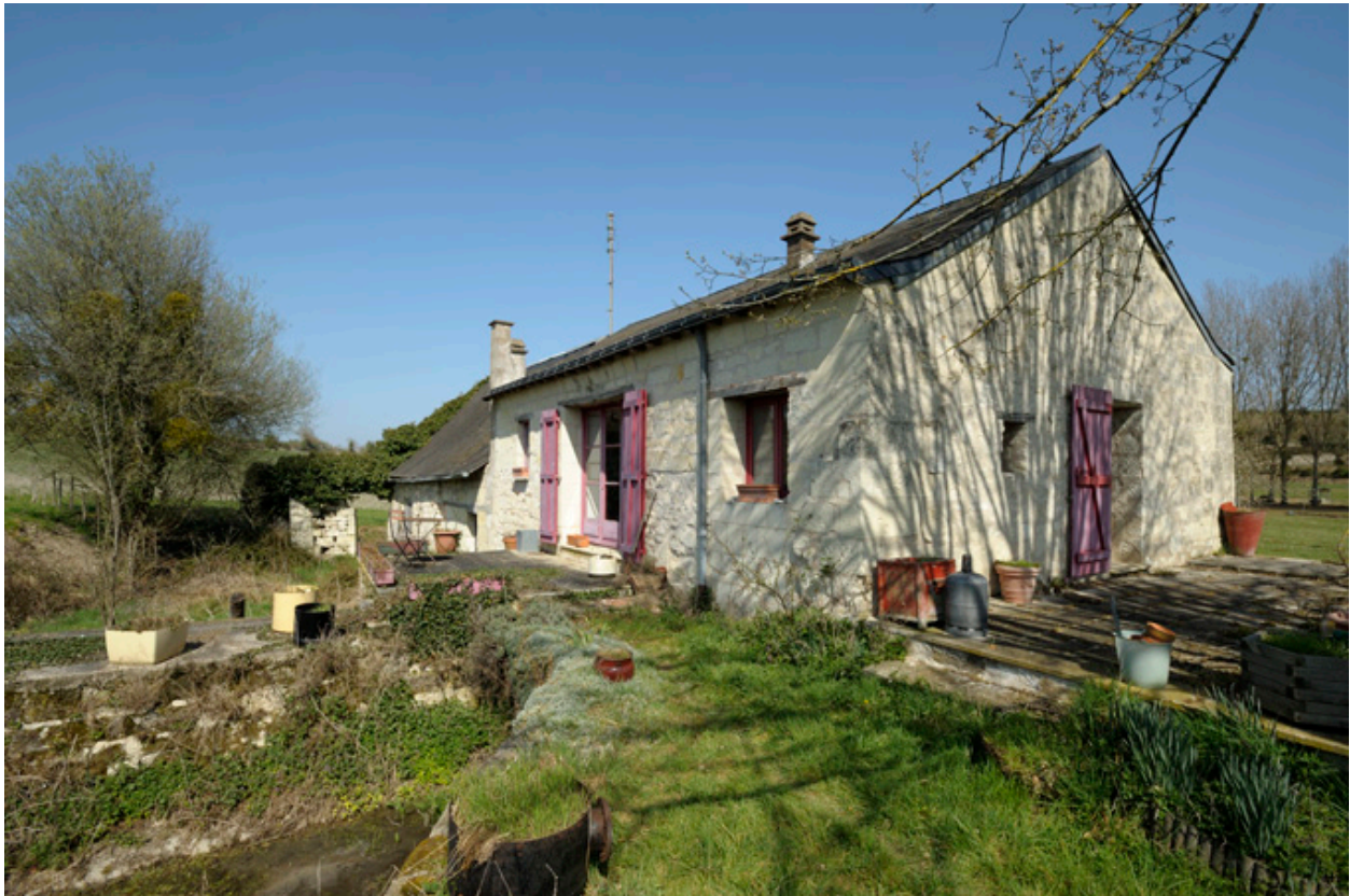
Corps ouest, abritant la roue du moulin.
