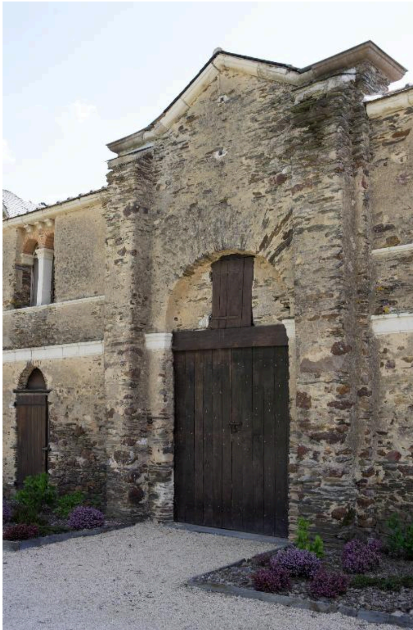
Bâtiment ouest, façade nord.
