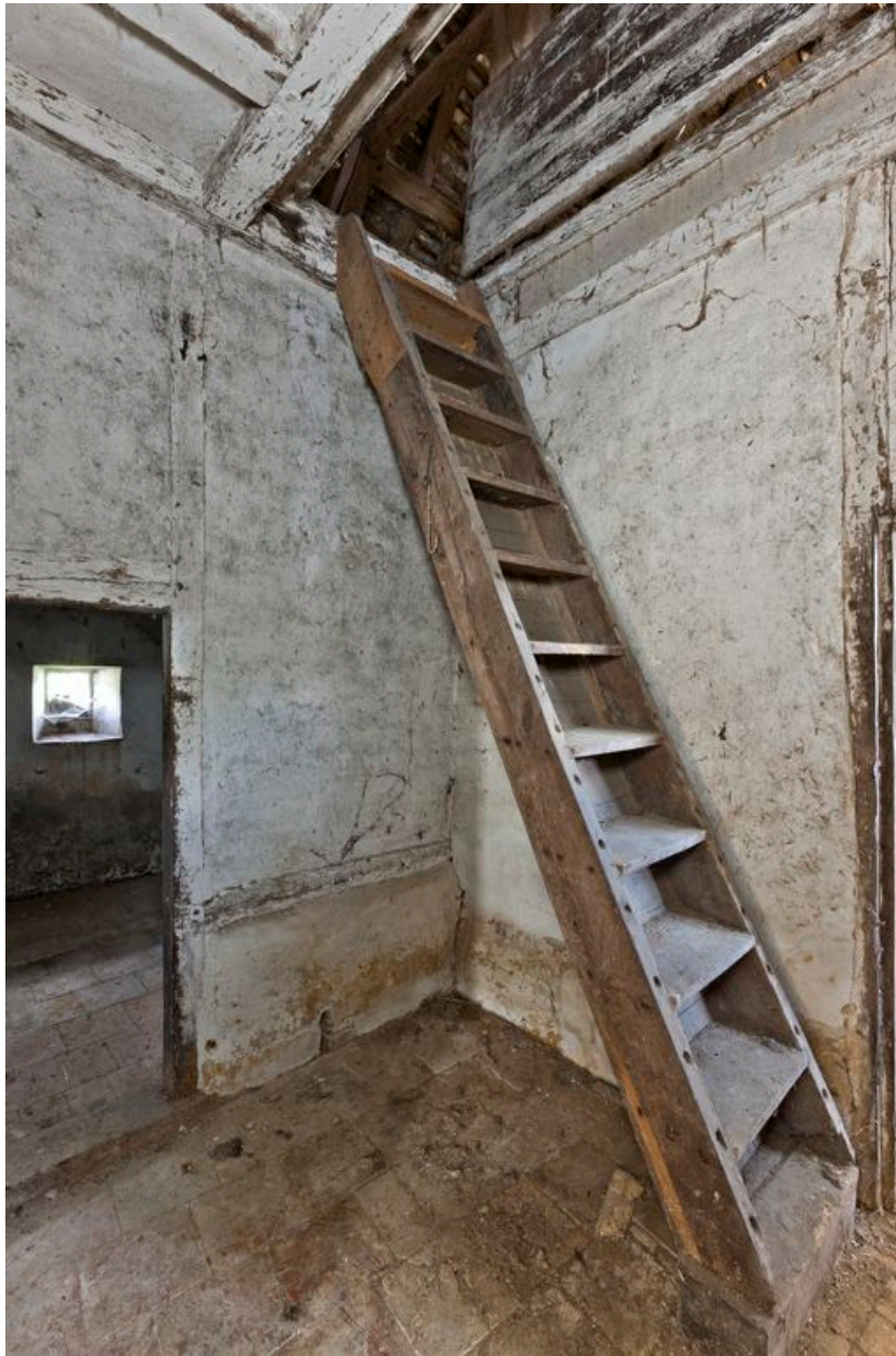
Echelle d'accès au comble.
