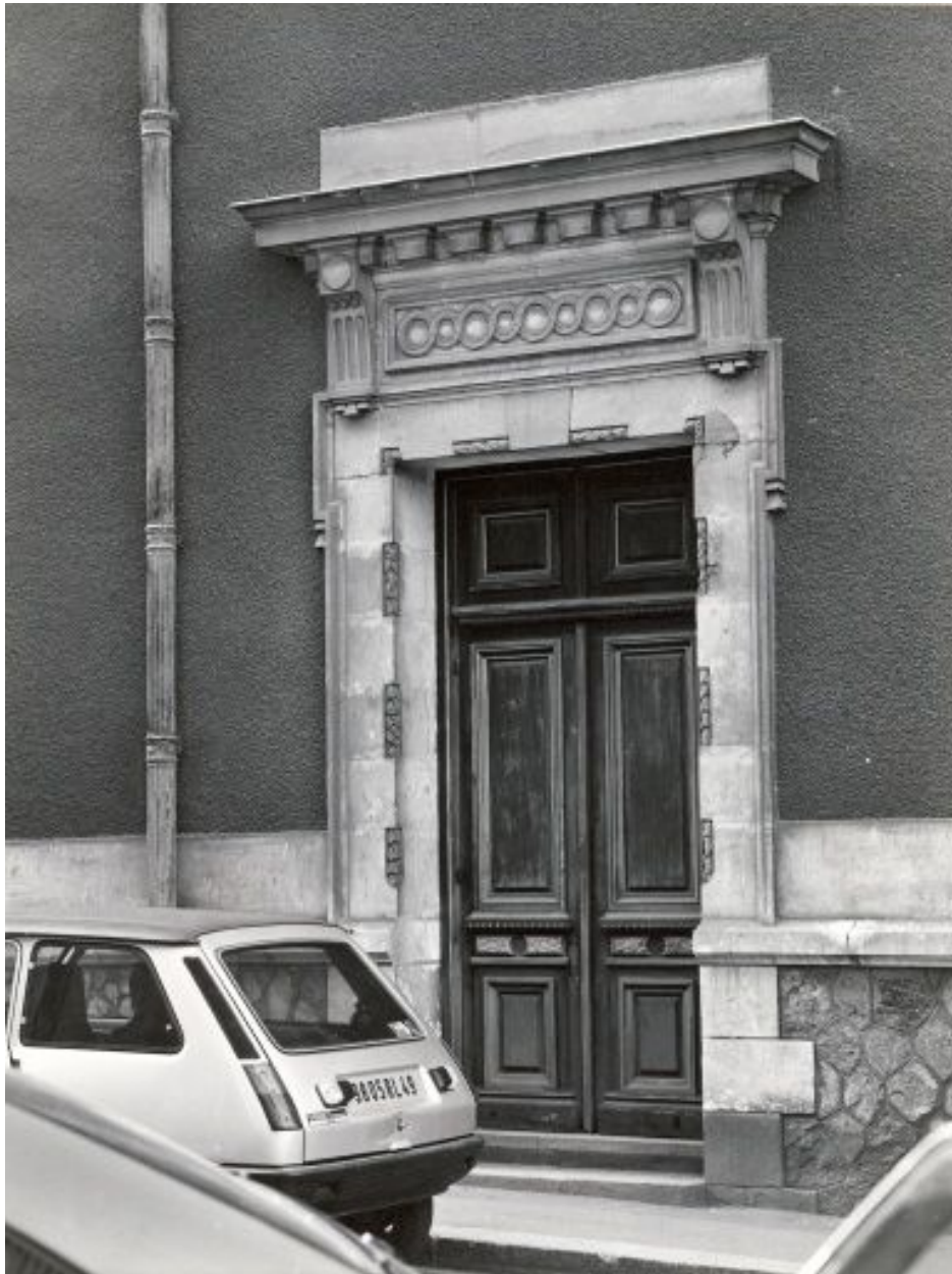
Façade latérale gauche, accès à la salle.
