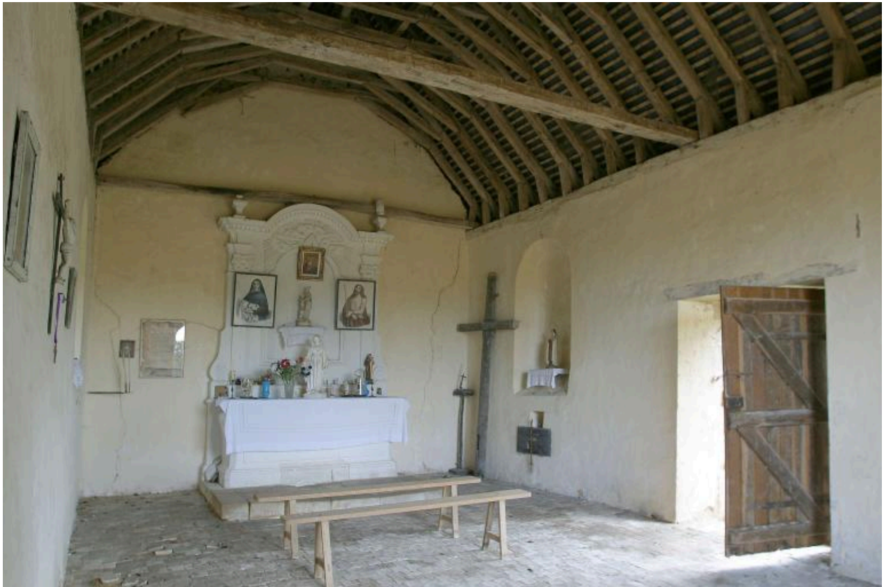
Vue intérieure depuis l'ouest.
