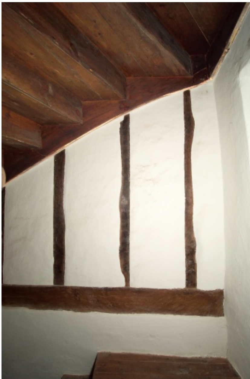
Cloison à pan de bois dans la cage d'escalier.
