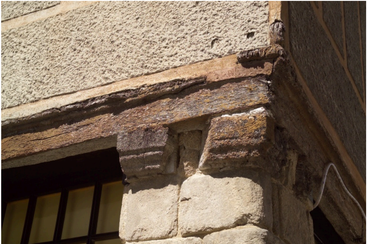
Détail à l'angle nord-est de la sablière basse.
