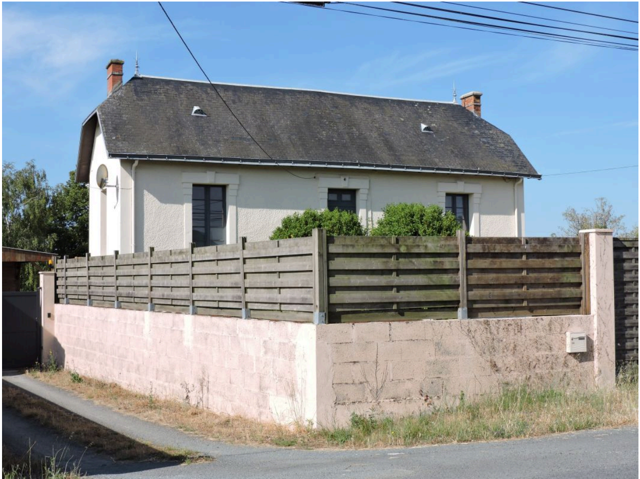
La maison vue depuis le nord-est.
