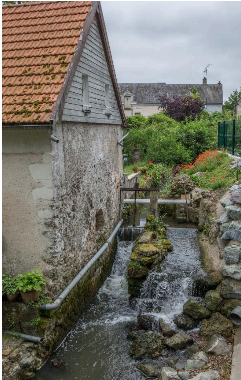
Rue A. de Tocqueville : mur-pignon du moulin du bourg, et vanage sur un bras de la Dême.
