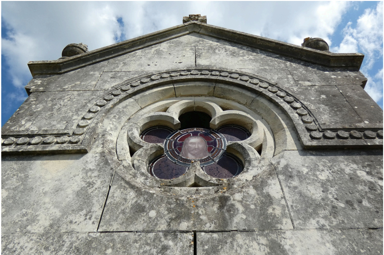
Détail du mur pignon postérieur : rose, bandeau, fronton.
