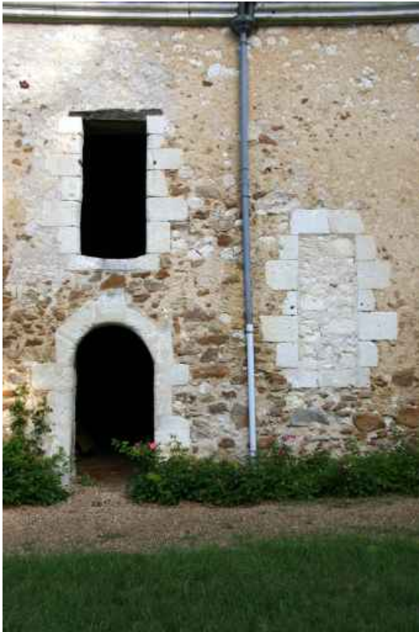
Porte piétonne sur la cour.
