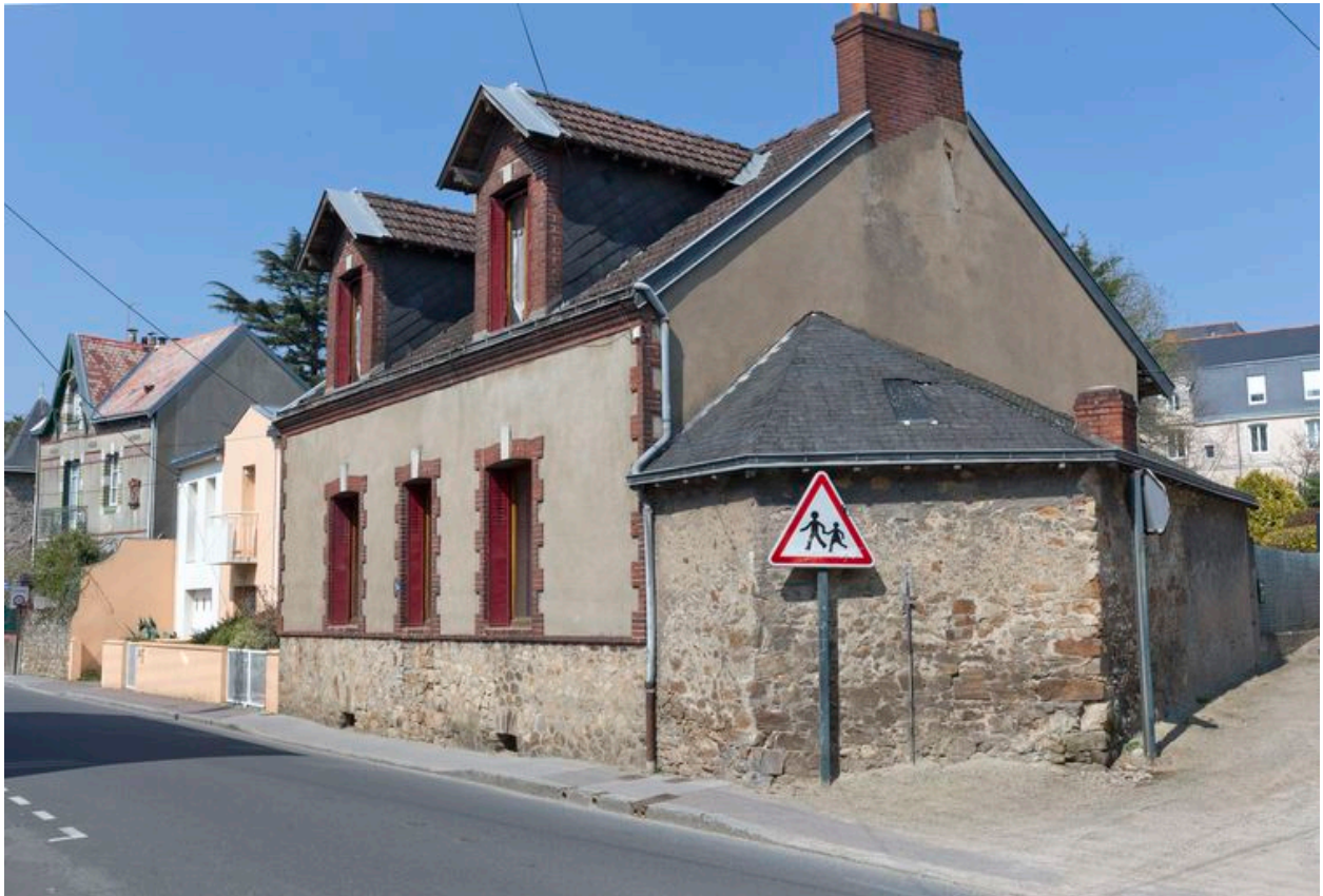
Maison n° 34, rue de l'Abbaye.
