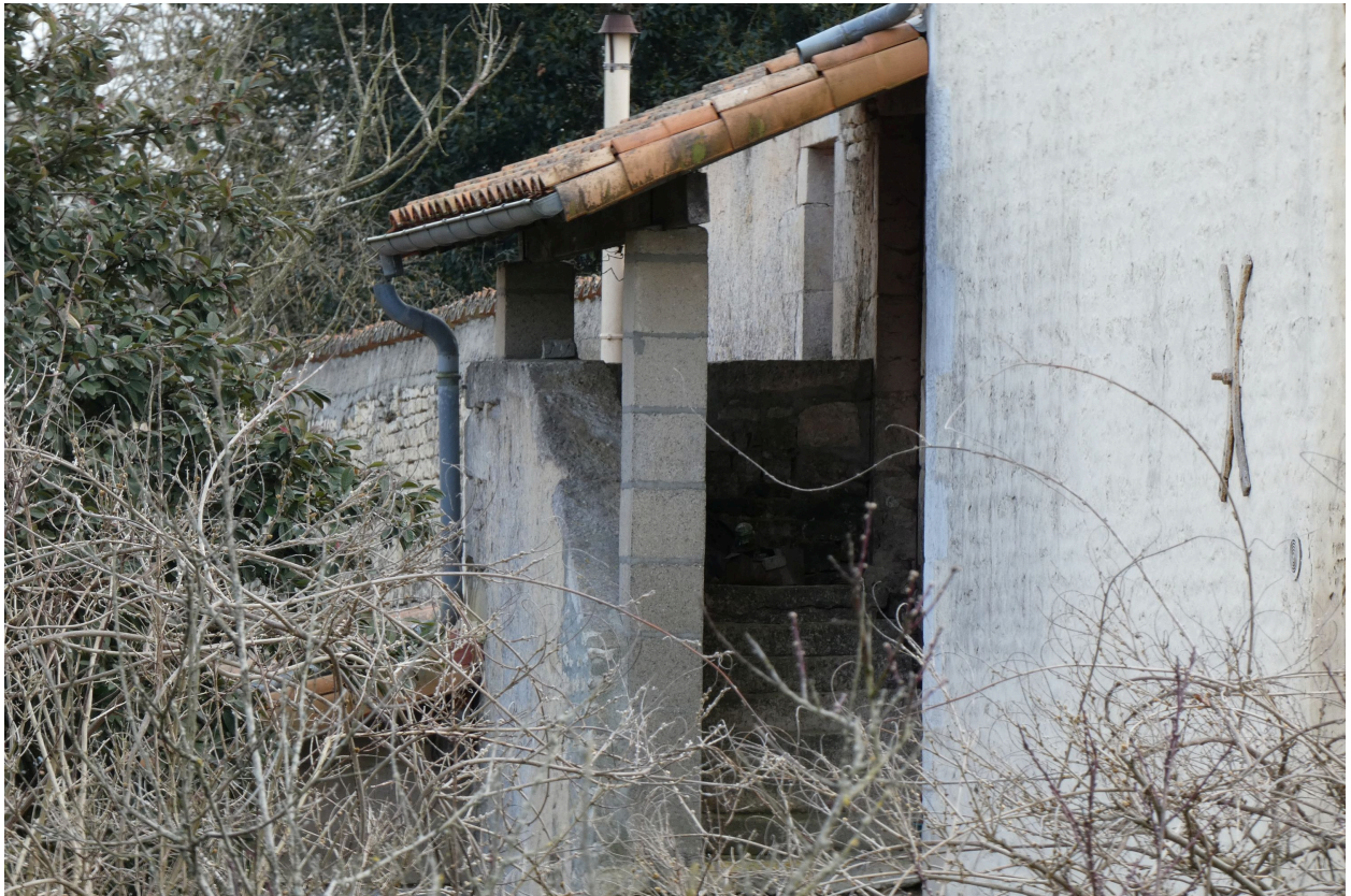
L'escalier extérieur à l'arrière des dépendances.
