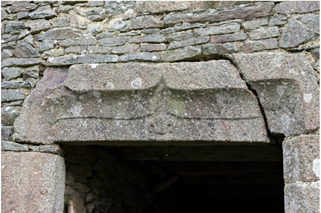
Linteau en accolade, alignement est, façade ouest.
