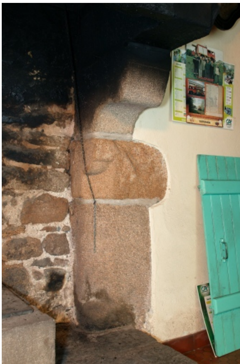
Cheminée, détail du piédroit droit.
