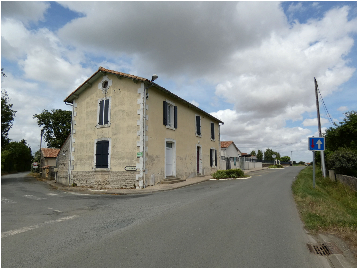
L'ancienne mairie et l'école en arrière-plan, vues depuis le sud-ouest.
