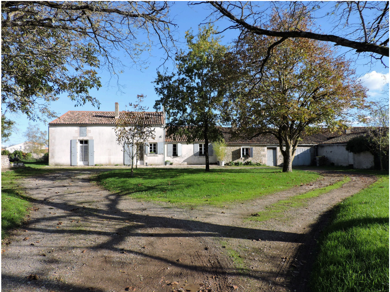
L'ancienne ferme vue depuis l'ouest.
