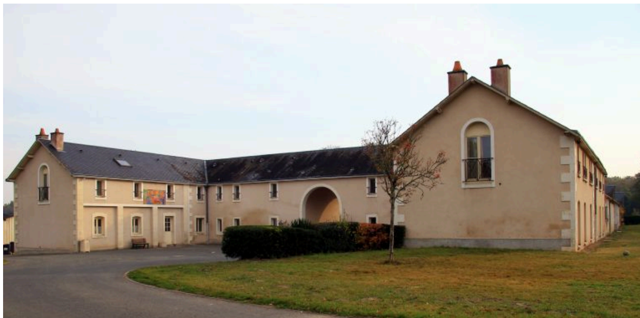
Les communs : vue de volume prise du sud-ouest.
