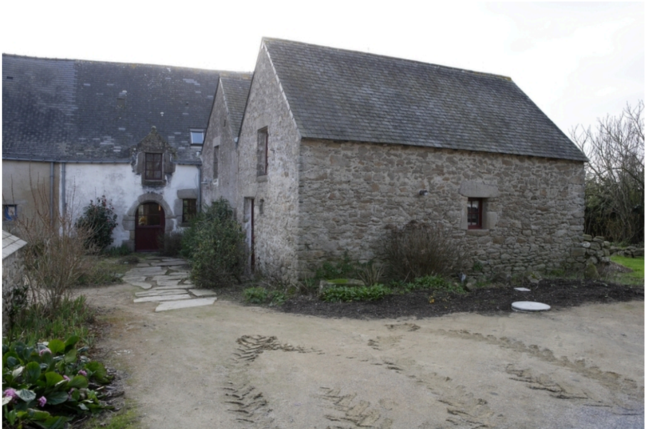
Vue d'ensemble depuis le nord (1 impasse Prémarie, fournil et dépendance).
