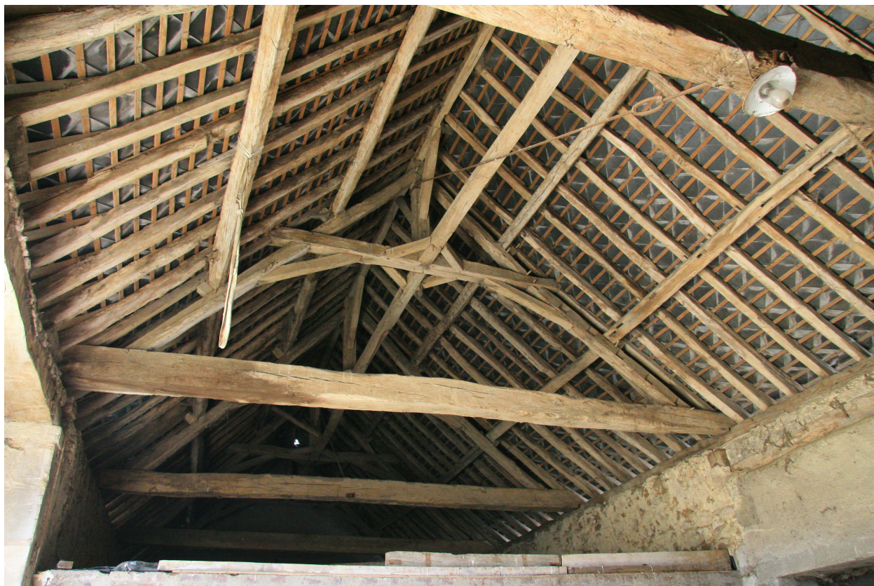
La grange : charpente à pannes sur poteaux.
