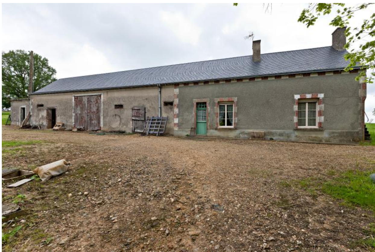
Ferme bloc à terre. La Baltière.
