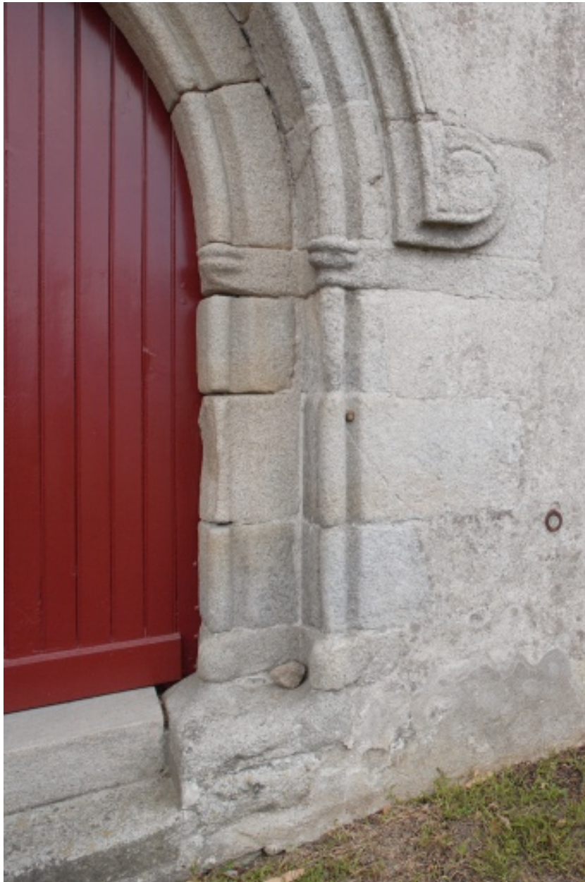
Détail du piédroit de droite du portail occidental.
