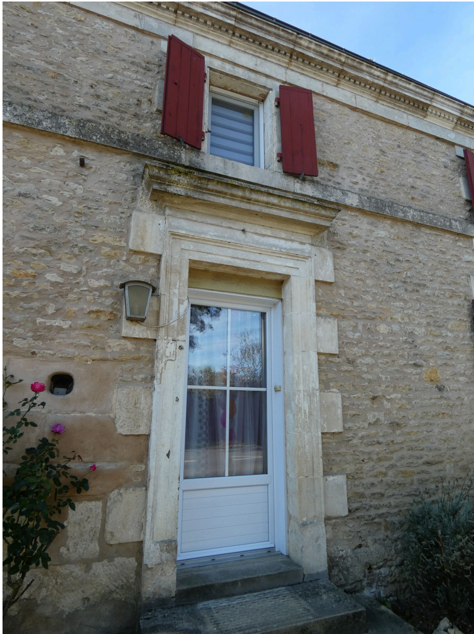
Détail de la façade : corniche à denticules, bandeau et la porte et son décor.
