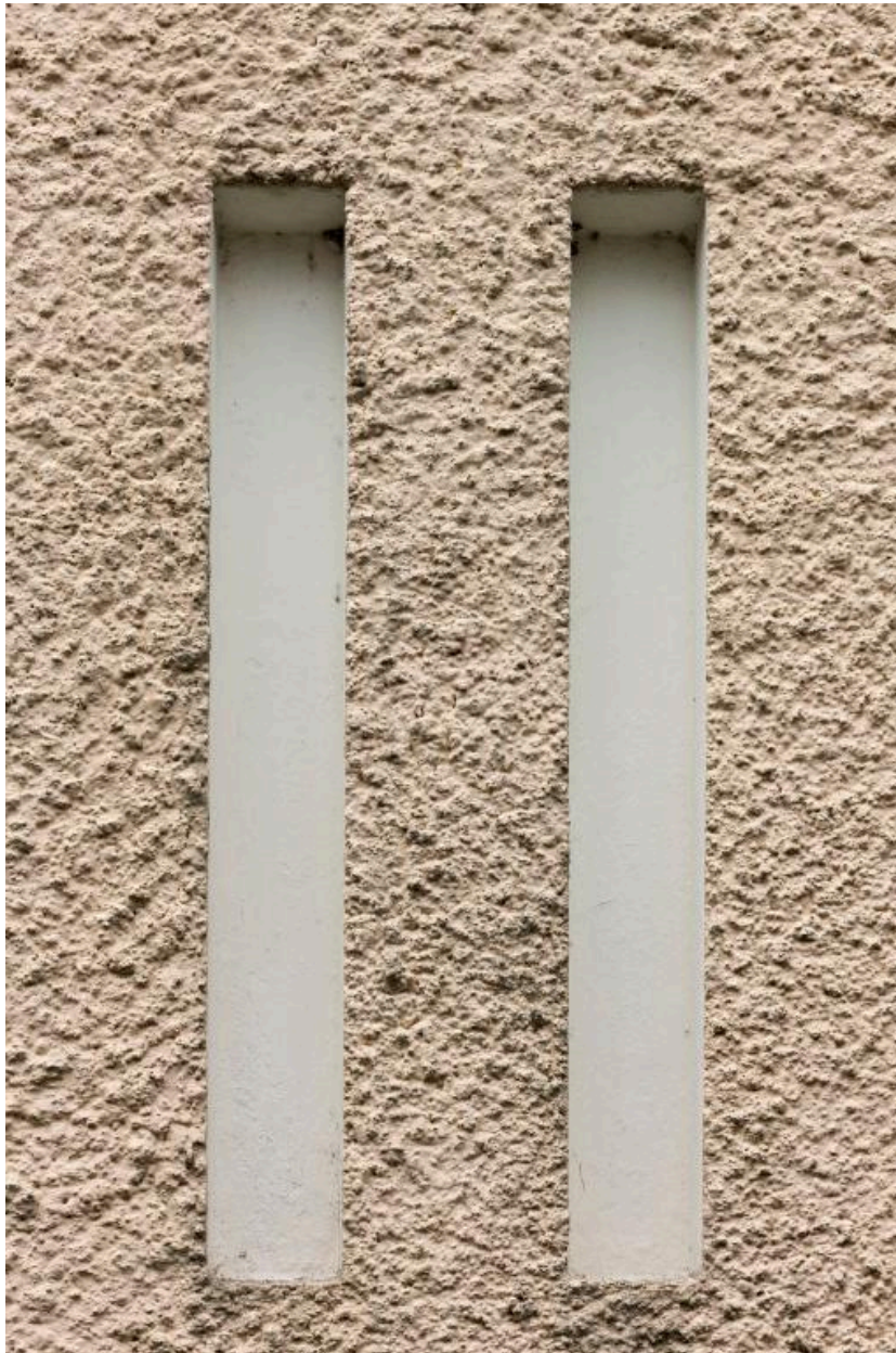
Elévation postérieure, détail.
