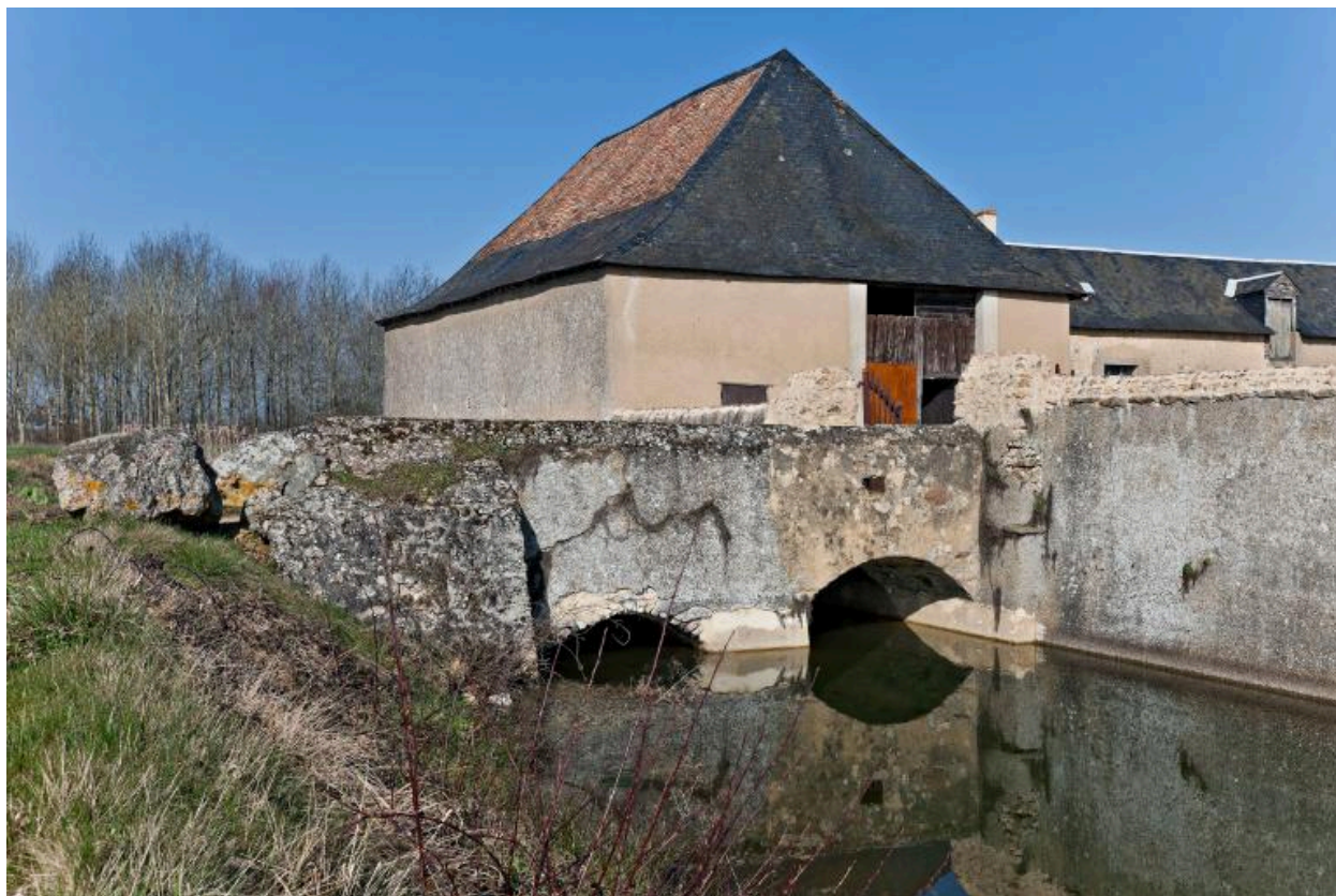
Pont d'accès à la cour centrale : face est.
