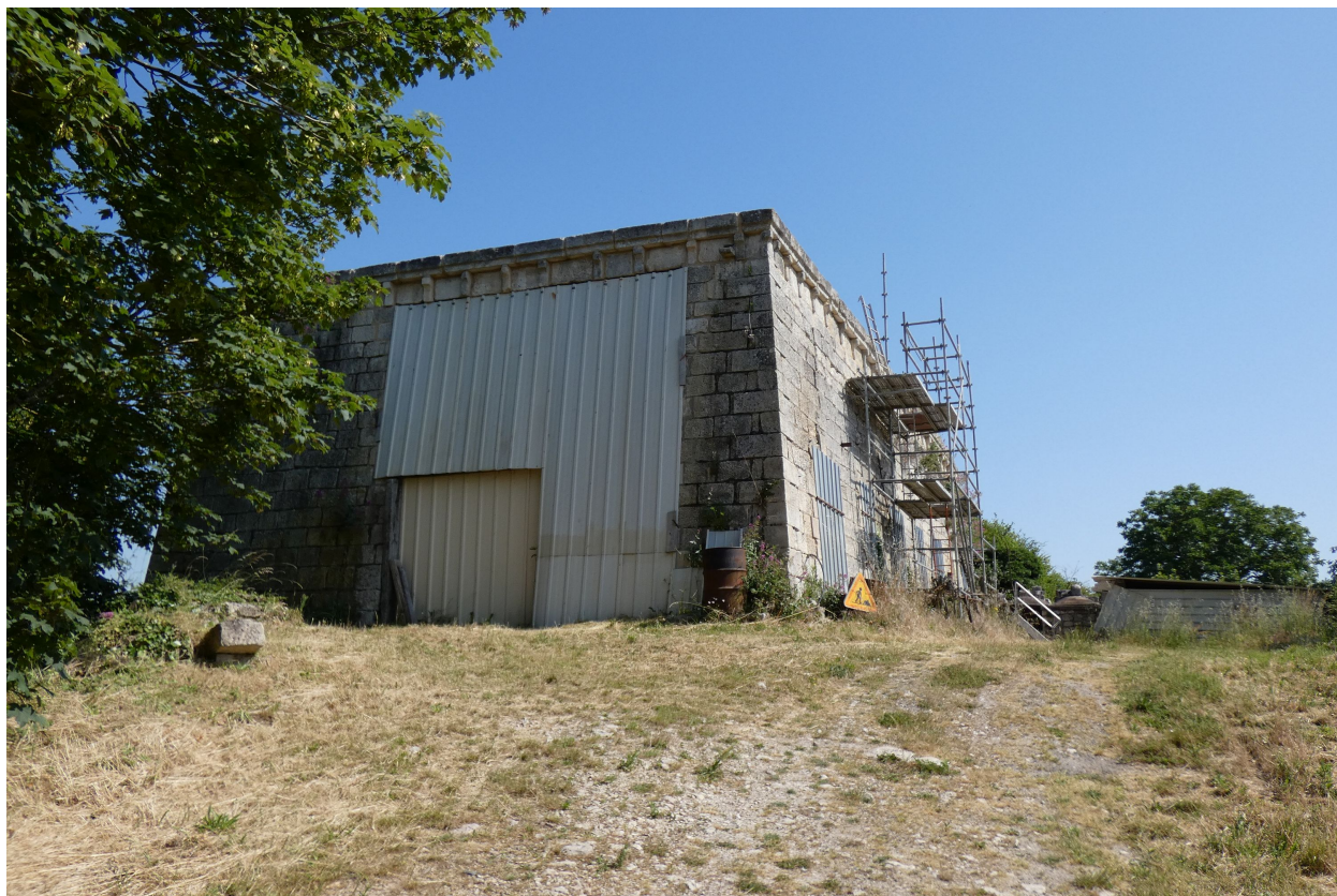
Le bâtiment des fours vu depuis le sud.
