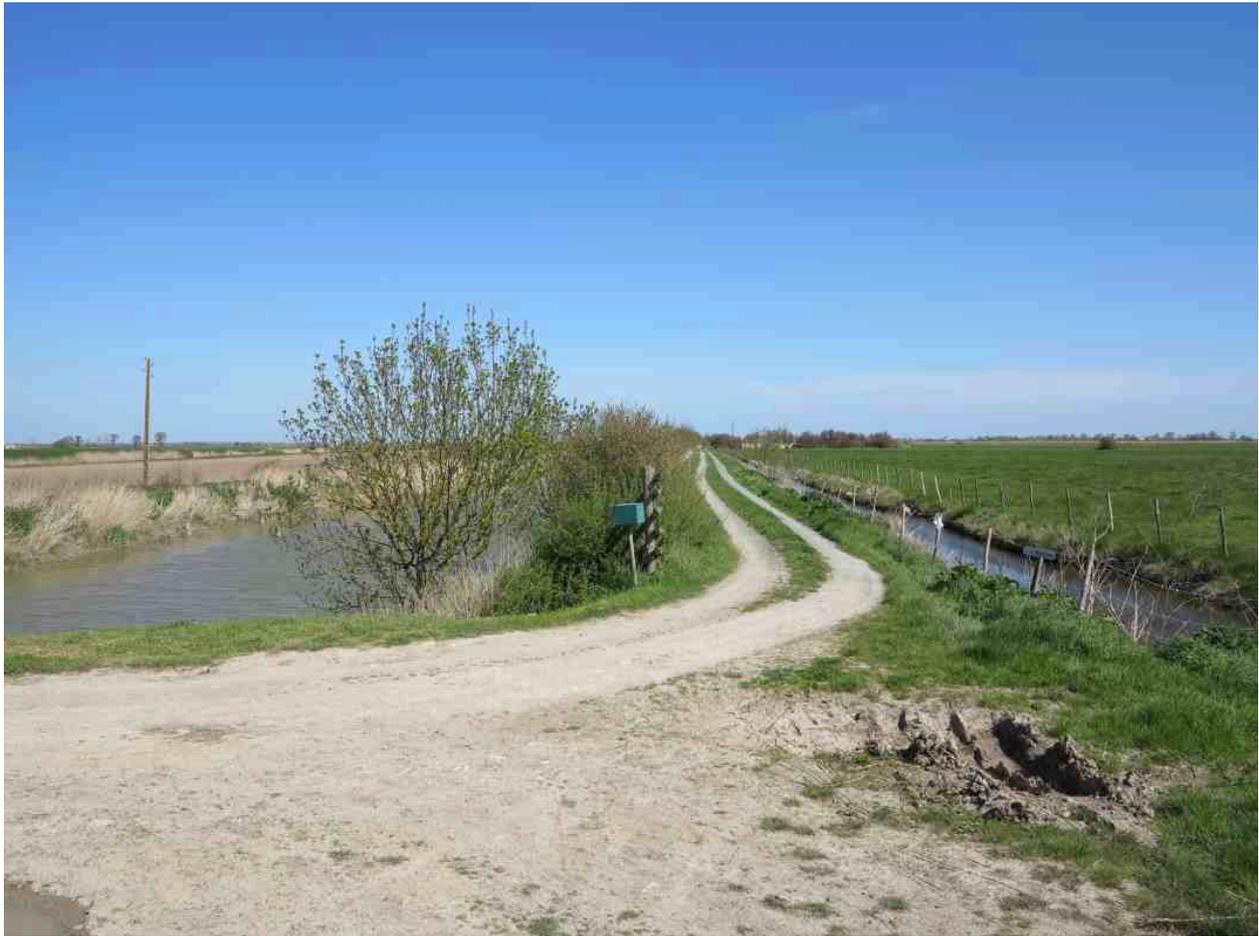
La Grande levée de Vix aux Portes de Vix, à Marans. De gauche à droite : les marais desséchés, le canal de Vix, la digue, le canal de ceinture extérieure, les marais mouillés.
