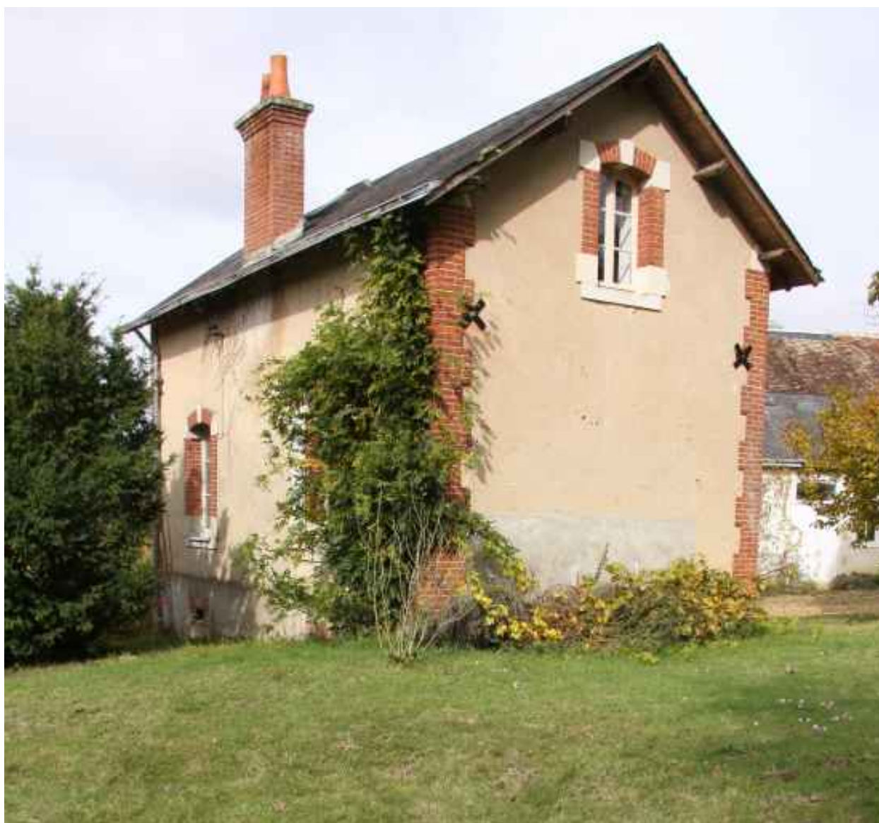
Les dépendances, vue de volume : pignon sud-est.
