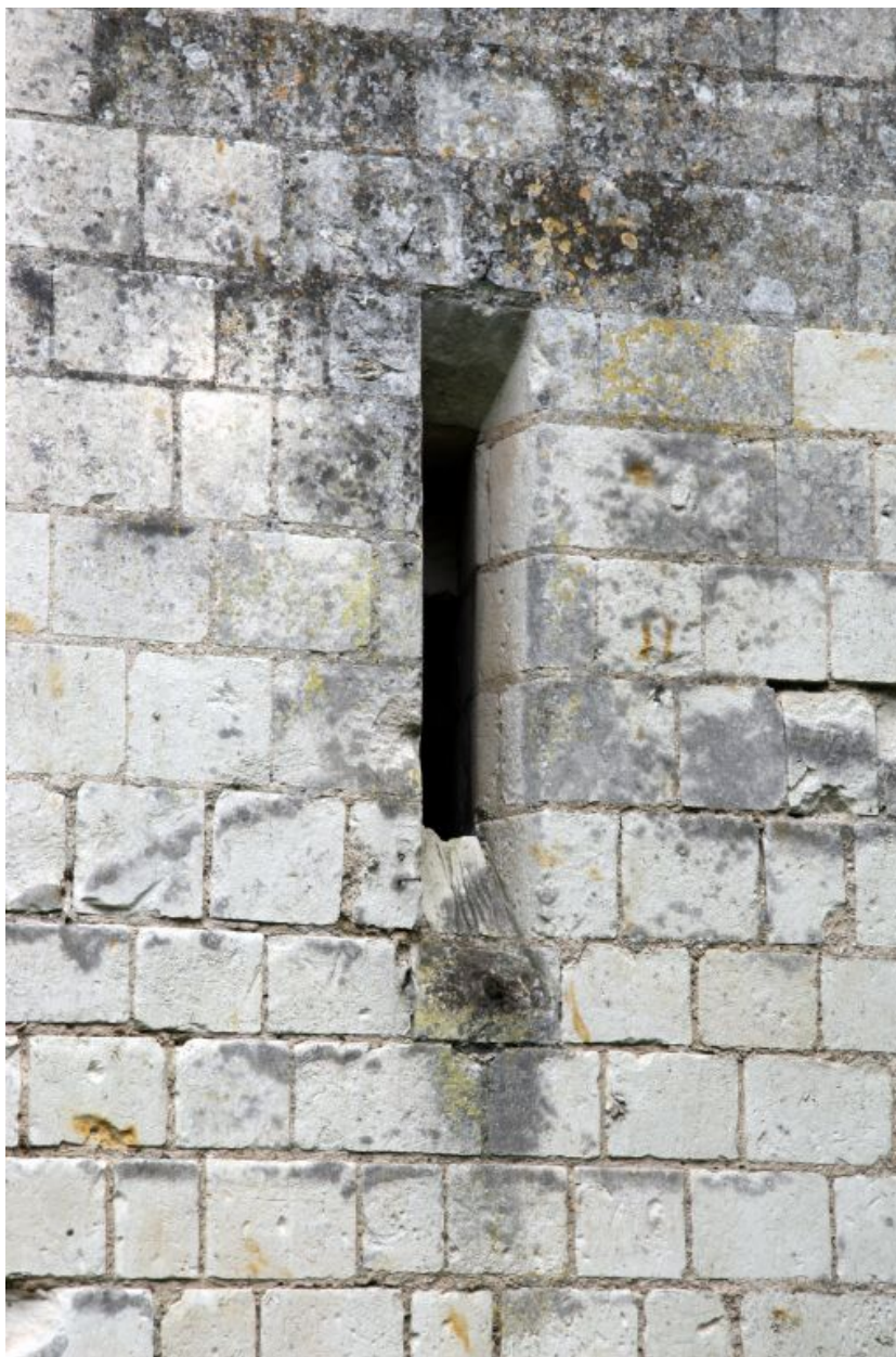
Ancien château, façade est : meurtrière.
