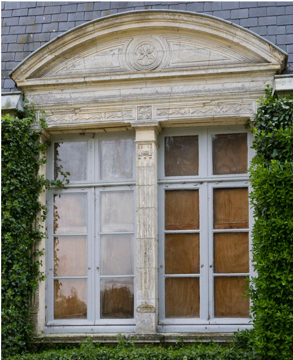
Fenêtre nord de l'aile ouest.
