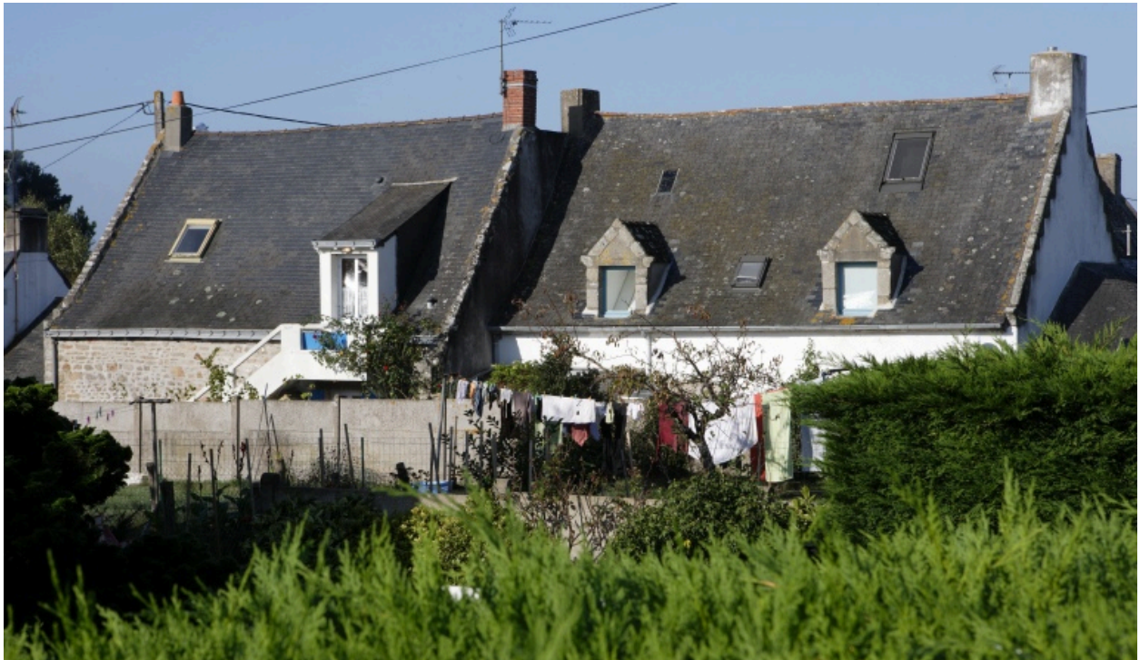
Vue de la façade arrière de la rangée depuis le nord-est.
