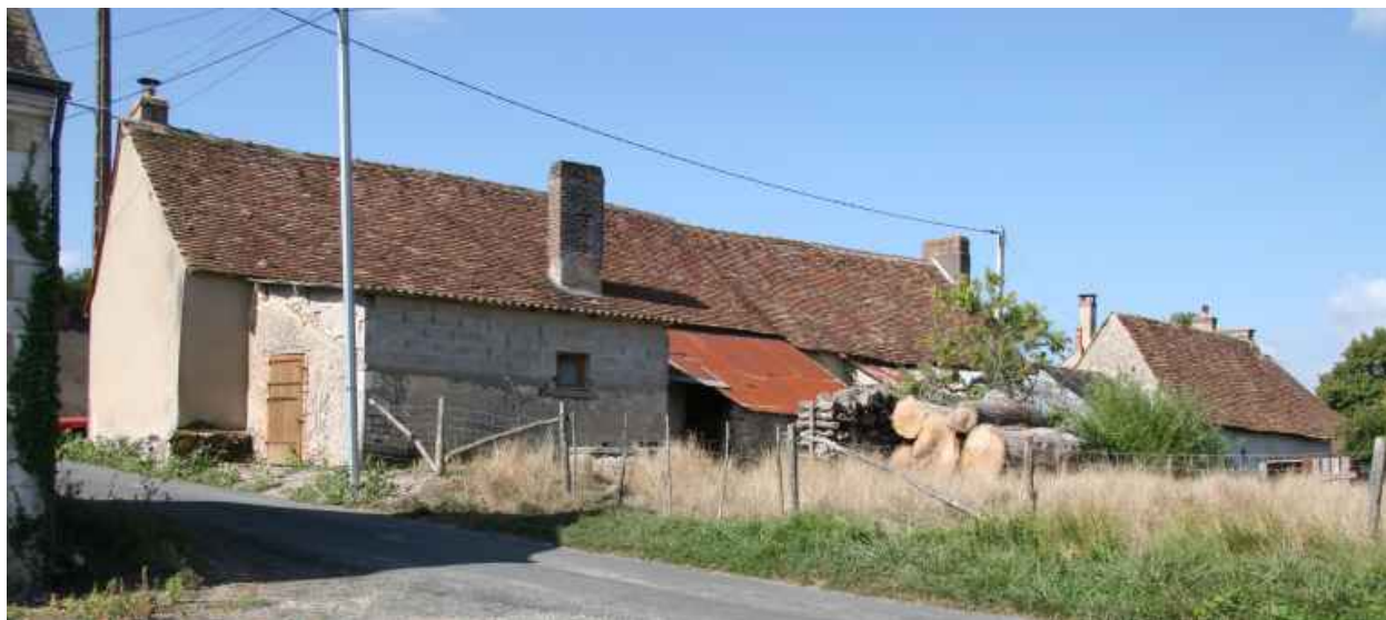
Maison n° 2 : façade postérieure.
