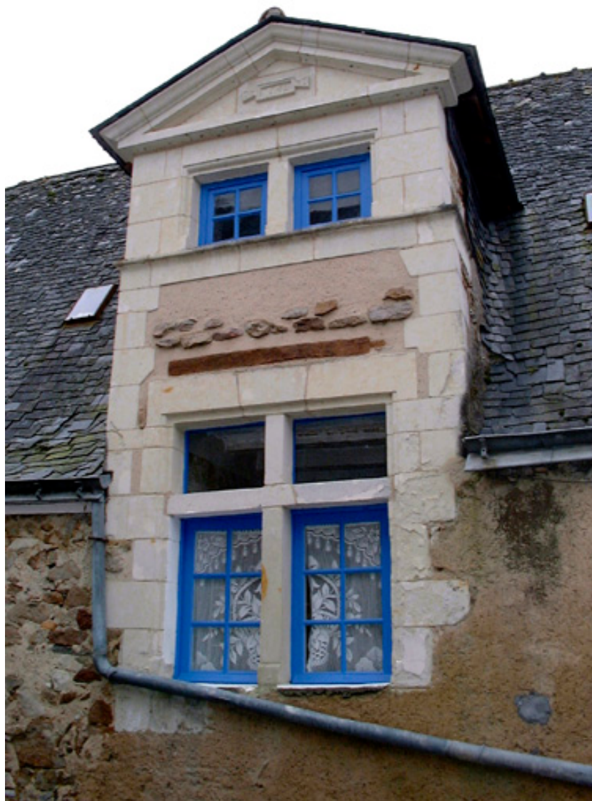
Détail de la lucarne datée 1563 sur le mur gouttereau nord.
