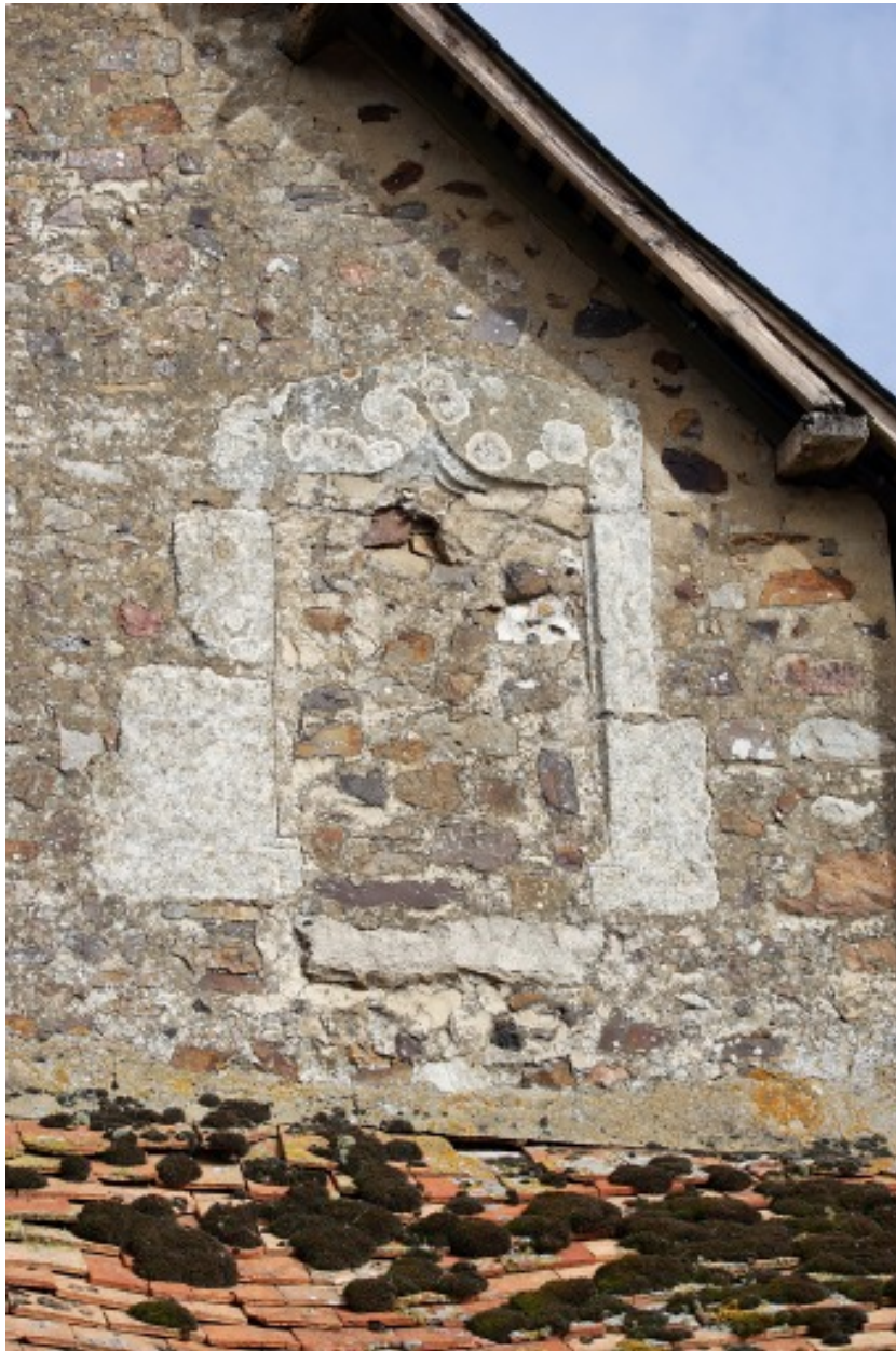
Détail de pignon sud : fenêtre bouchée.
