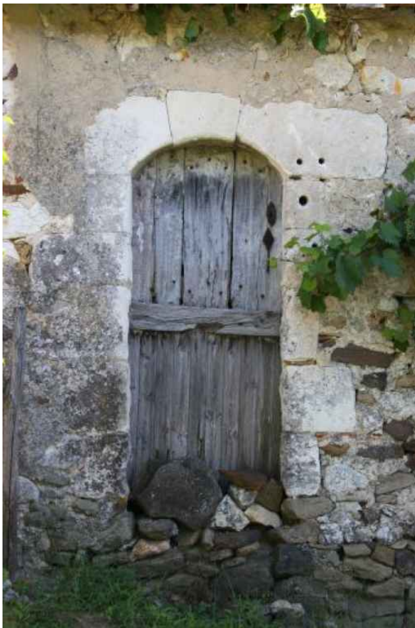
Maison 2 : porte d'entrée couverte en anse-de-panier et menuiserie de porte à deux battants.
