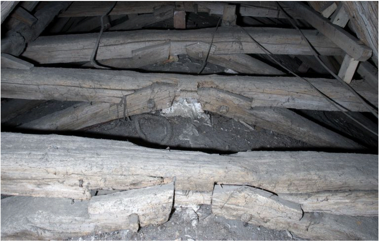
Charpente du choeur, 2e, 3e et 4e fermes, côté ouest : détail d'assemblage entre le faux entrait et les arbalétriers.
