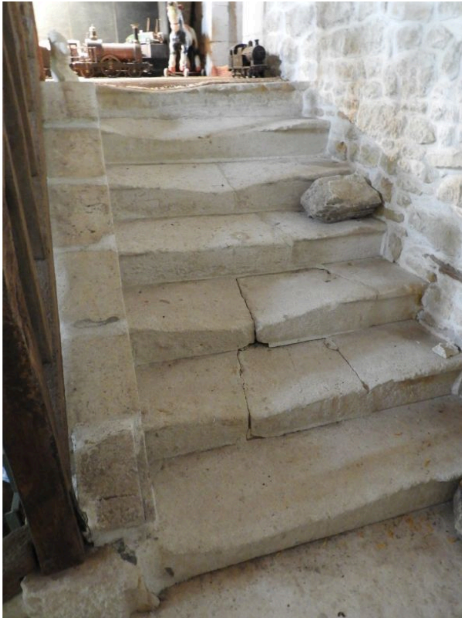
L'escalier en pierre à l'intérieur du logis : seconde volée droite.
