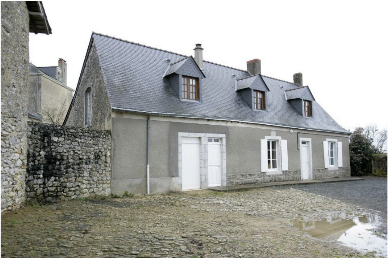
Le logis de ferme vu depuis la cour à l'est.
