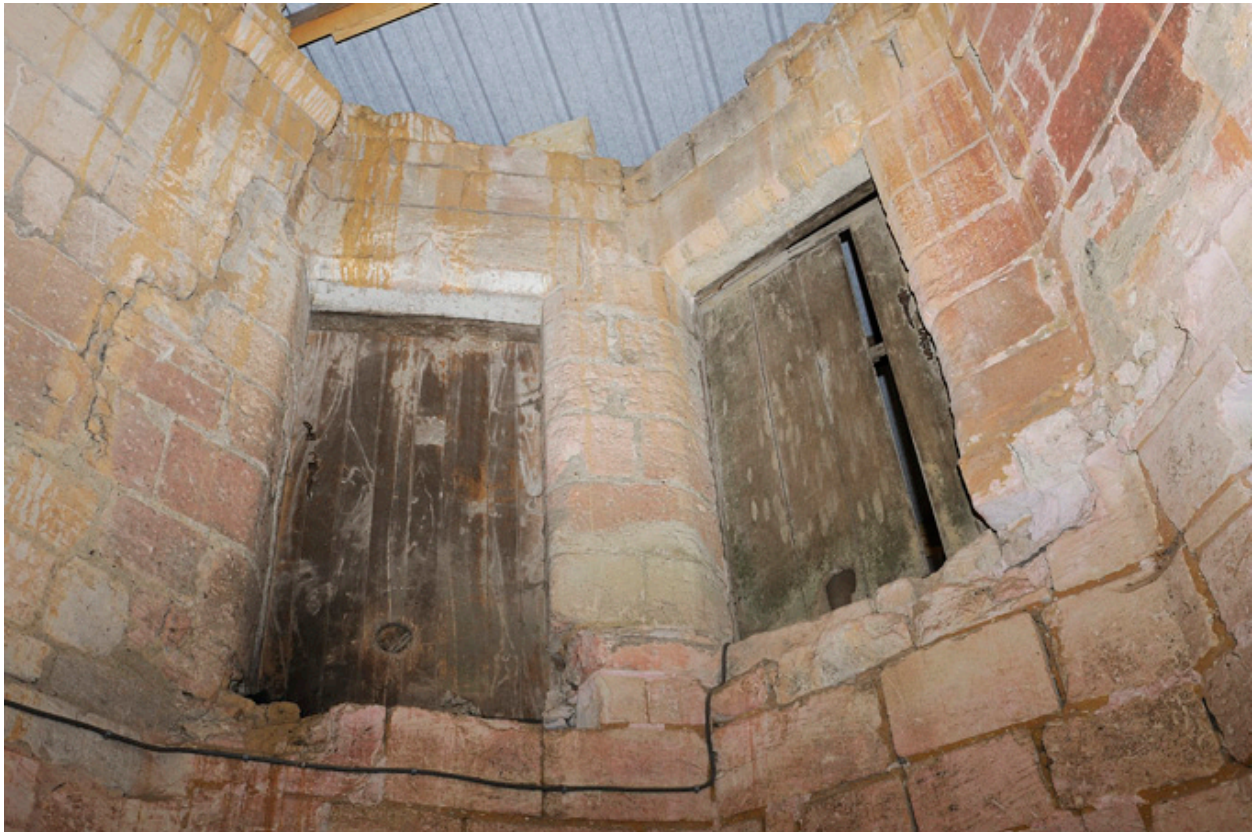
Tourelle d'escalier, portes des salles l'étage : à gauche salle est, et à droite salle ouest.
