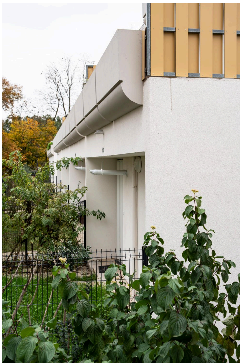
Détail d'un rez-de-chaussée surmonté d'une terrasse.
