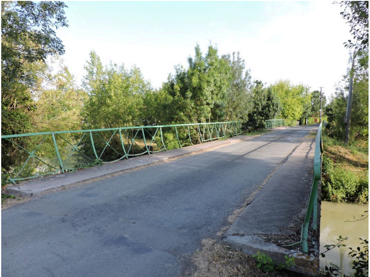
Le pont central, sur le canal de Vix, et le pont nord, sur le Petit canal de la Société, en arrière-plan, vus depuis le sud.
